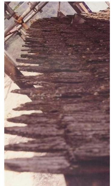
anciens bardeaux lors de la réfection - Automne 1997
