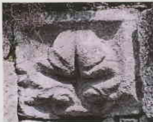
Chapelle rez de chaussée Sommier de voute
