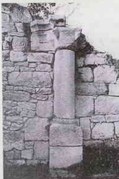
Chapelle rez de chaussée Colonne du mur nord
