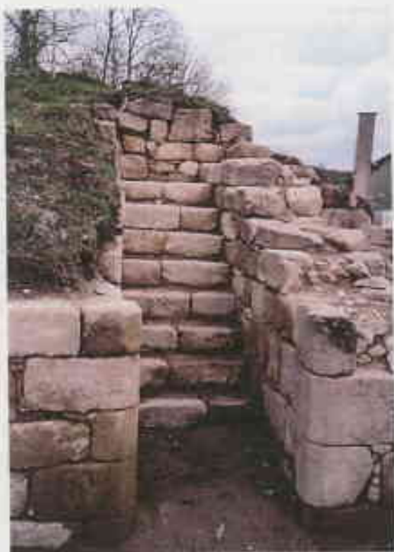
Escalier dans le rempart à la Porterie Découvert lors des travaux en mai 2004
